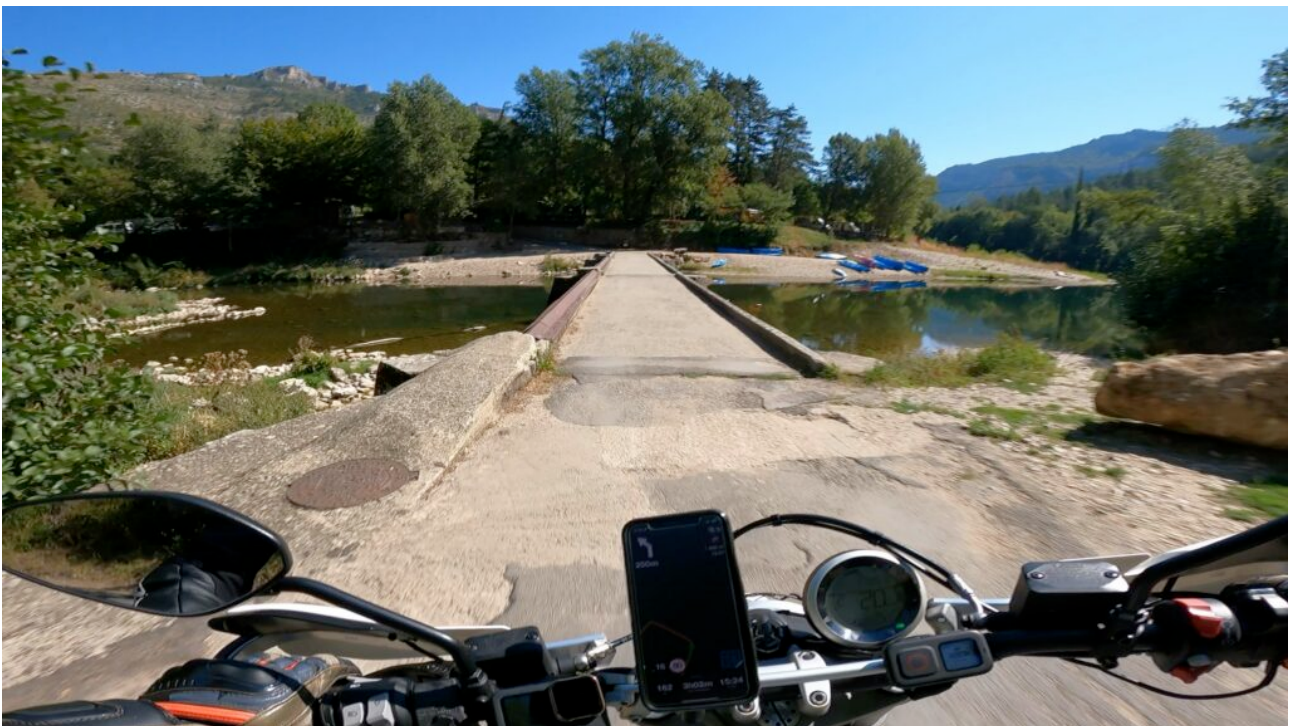
Pont submersible sur le Tarn au niveau de Castelbouc
