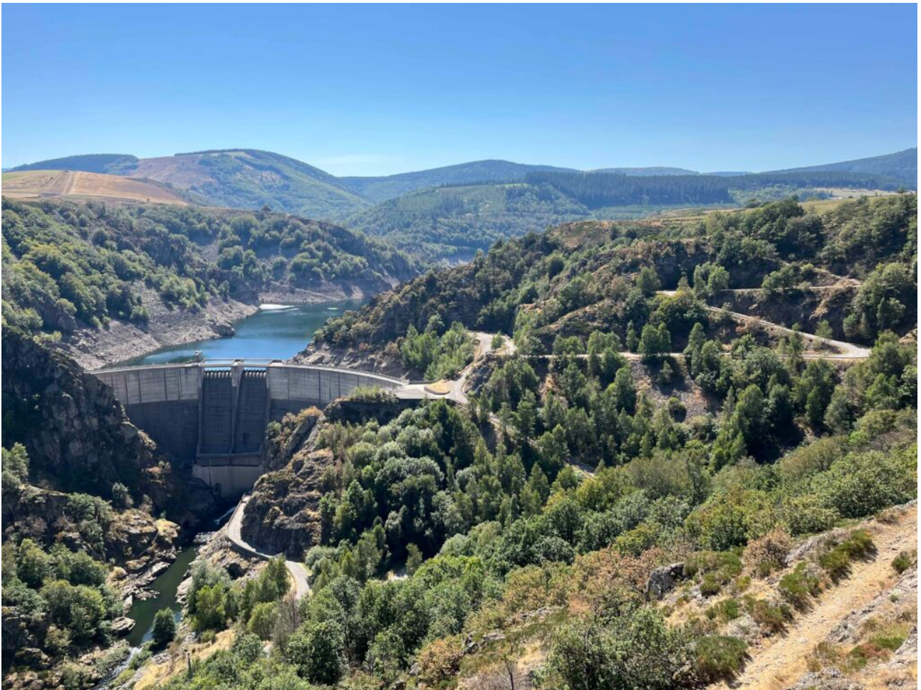
Barrage de Puylaurent sur le Chassesac
